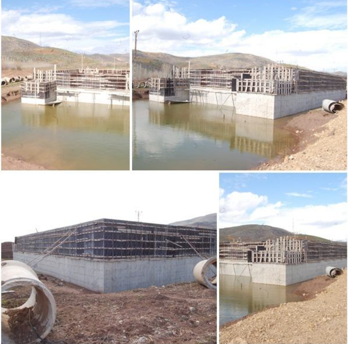
Atık su arıtma tesisi inşaat çalışmaları 2012 yılında başlamıştır.
